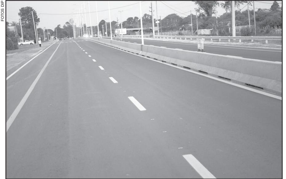
**NUMERADOS.** Las tareas ejecutadas incluyen ampliación de calzada, construcción de retornos, instalación de defensas, iluminación, garitas, dársenas de colectivos y desagües.
